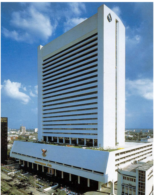
โครงการ BBL Silom Head Office Renovation
